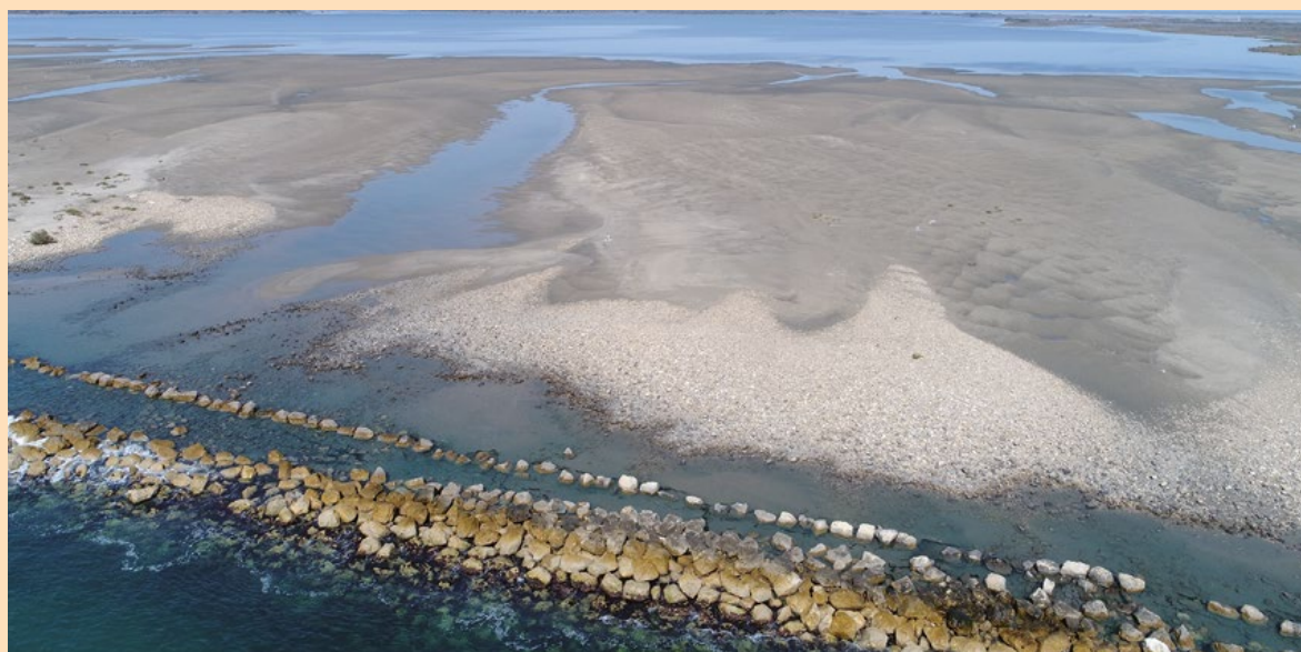
Digue frontale en cours d'affaissement avec apports des sédiments par la mer permettant la reconstitution d'un lido sur le site des étangs et marais des salins de Camargue. © Antoine Arnaud et Loïc Willm, Tour du Valat.
