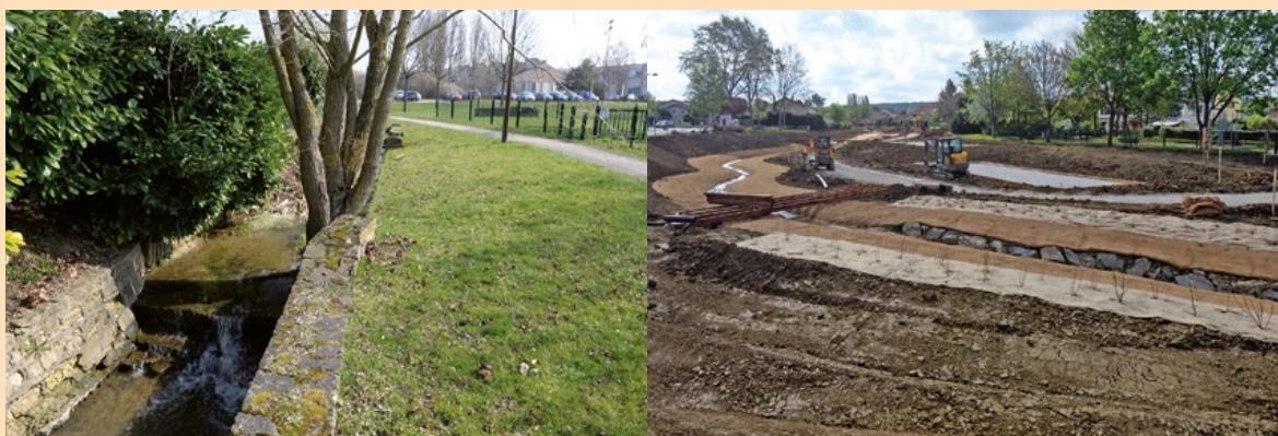
Le ruisseau du Grémillon dans la traversée du parc de Pulnoy (aménagement d'un lit majeur, re-méandrage et renaturation des berges). © MGN (Frédéric MERCENIER).
