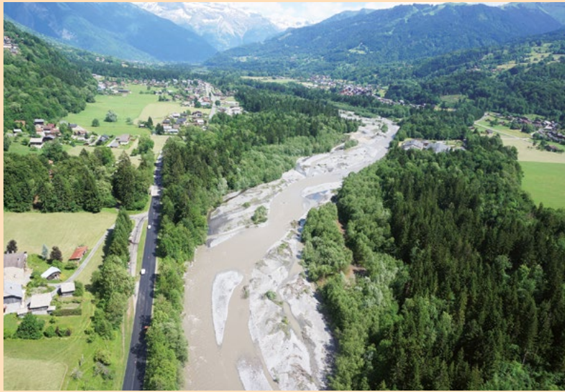
Image aérienne post travaux. © SM3A
