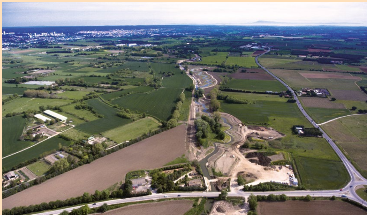
Le Vistre à Milhaud après les travaux en 2016. © Agora Communication
